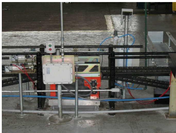
Instalación de sistemas cw y dcw sobre conveyors existentes
